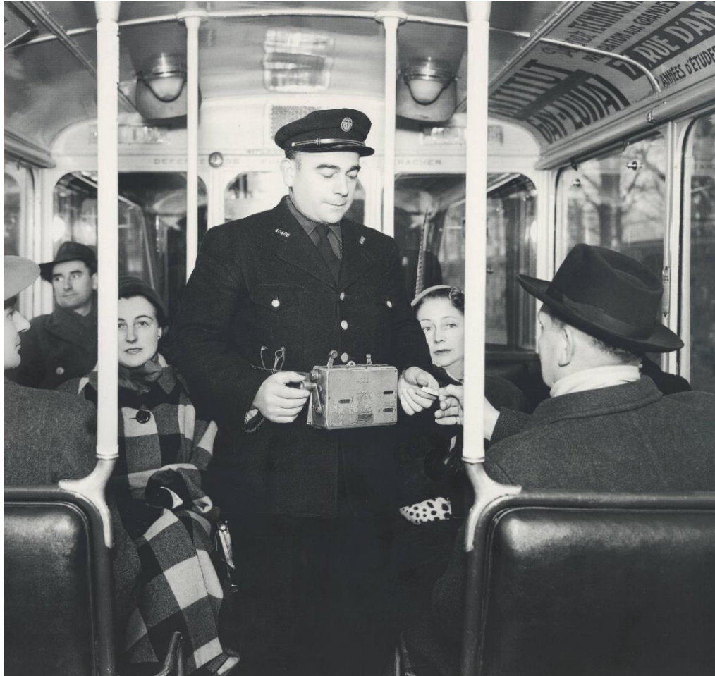
Durant toute cette période, la perception par le receveur et l'oblitération des tickets sont toujours effectuées avec la célèbre « moulinette », composteur de la Sté CAMP (Construction d'Appareils Mécaniques de Précision) fixé sur un baudrier autour de sa taille. (coll. MJ)
